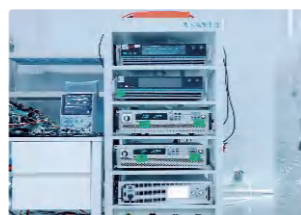
测试电源平台
